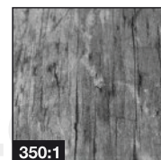
Superficie agrietada por estrés mecánico.
